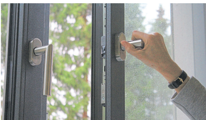
Dauerkipplüften sollte vermieden werden, da es einen geringen Luftaustausch begünstigt.
