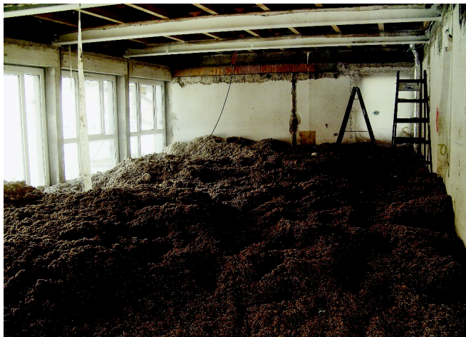
Dieses Foto zeigt die aus dem Deckenbereich entfernten Zelluloseflocken.
