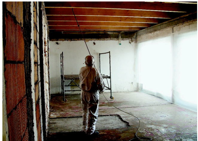
Mit Hilfe der Sprühlanze wurden die Oberflächen im Deckenbereich mit Schimmelpilz-Entferner entkeimt.
