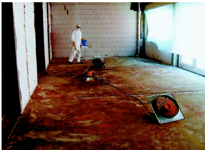
Nach dem Abtöten und Entfernen des Schimmelpilzes wurden die Räume mit Sporenvernichter vernebelt.
