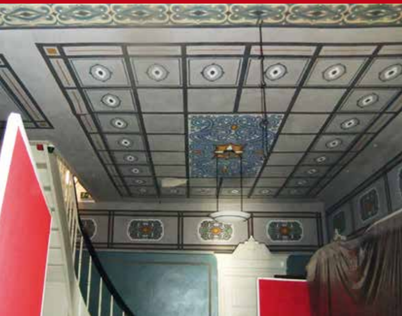
Als Träger des Deckenputzes waren auf Schalbrettern aufgebrauchte Strohmatten verwendet worden
